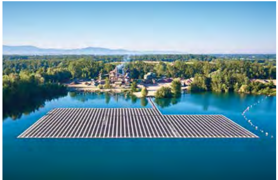
Wasserkraft? So ähnlich. Schwimmende Photovoltaikanlage auf dem Baggersee Maiwald im Ortenaukreis
